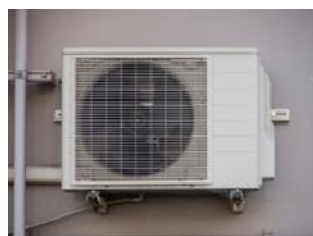
⑤壁面設置
