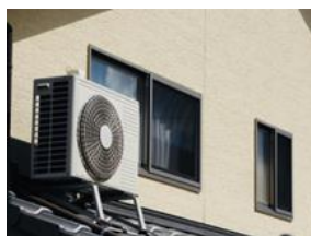
⑥屋根置き工事
