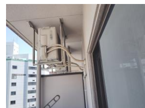
⑦天吊り工事
